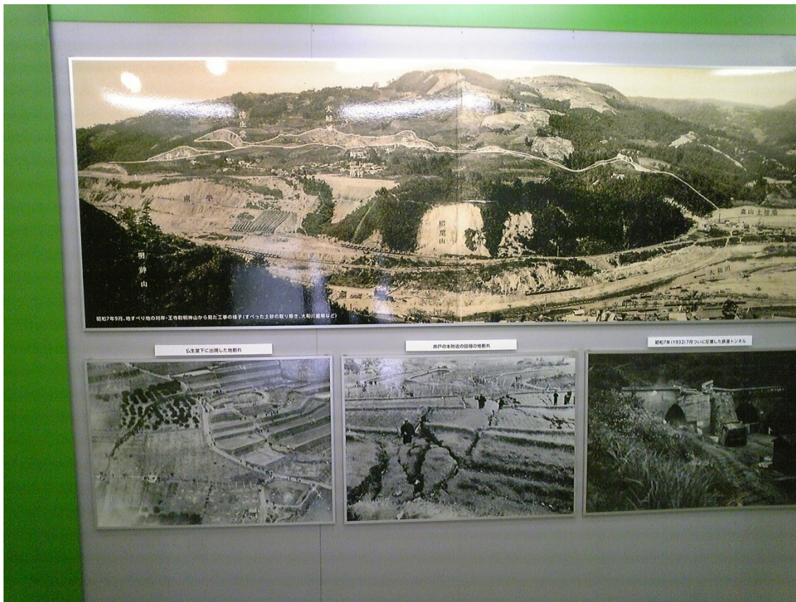
（上部写真の白く見えているところが地すべり部分。復旧工事写真・昭和7年9月撮影）
